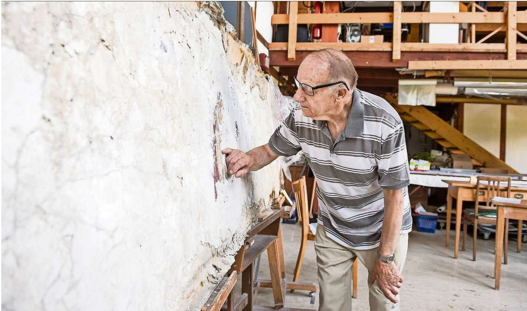
Den Geheimnissen auf der Spur: Oskar Emmenegger untersucht ein Wandstück aus Pontresina, bei dem unter Putzschichten alte Malereien liegen.
